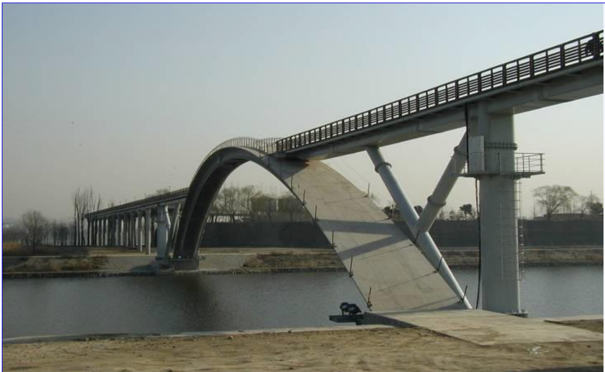
Passerelle de Seoul (Dalle : 3 cm d'épaisseur)
