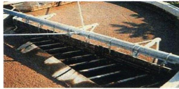
**Fig. 110** - Epaissement par flottation
