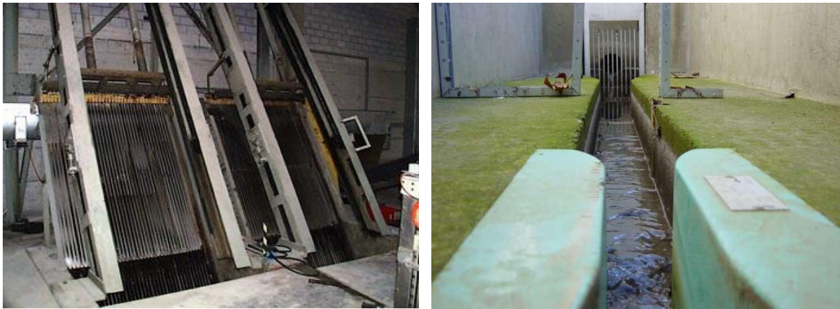
Figure 8 Système de dégrillage des eaux usées urbaines [7]
