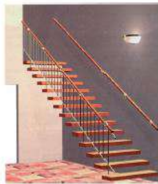
Figure 6.22 : Marches en console sur mur
