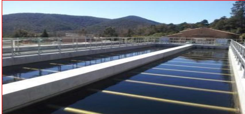
Figure II.8. Décanteur rectangulaire
