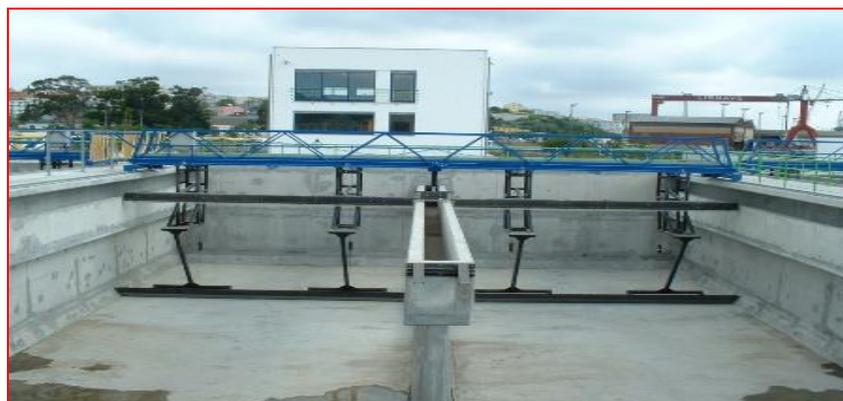
Figure II.9. Pont racleur – Décanteur longitudinal
