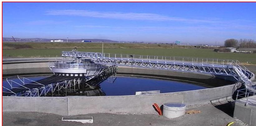
Figure II.7. Décanteur circulaire
