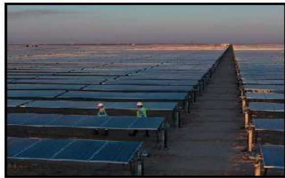
مشروع محطة جدة للطاقة الشمسية
