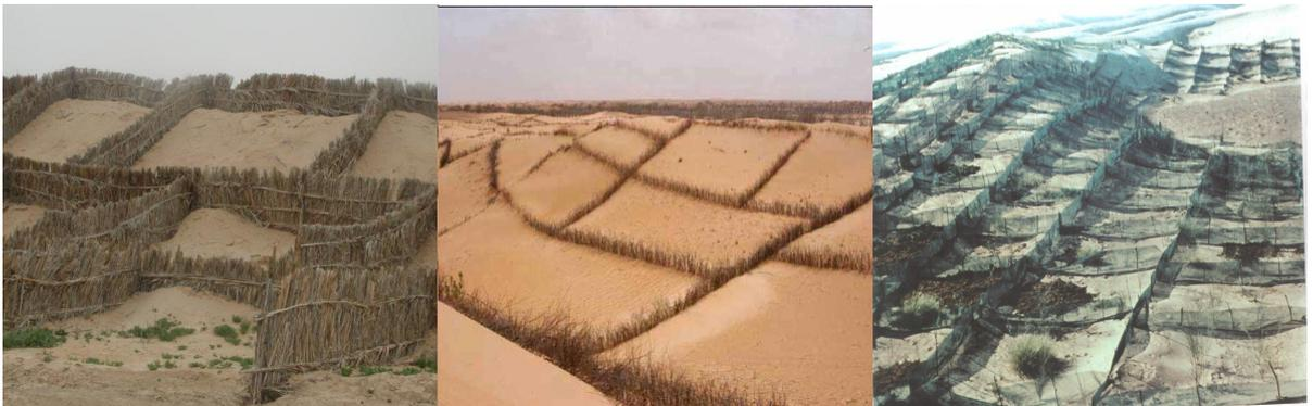
issades), capables à la fois de stabiliser les sables et de réduire ou d'assouplir la vitesse des vents, en laissant un pourcentage du sable s'infiltrer à travers le maillage des palissades, la perméabilité doit être de 40 à 60 %.
