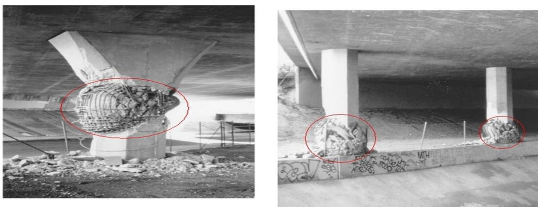
Fig. 6 Rotules plastiques des piles des ponts(Source : Moehle, J.P., Eberhard, M.O, 2000) [5].
