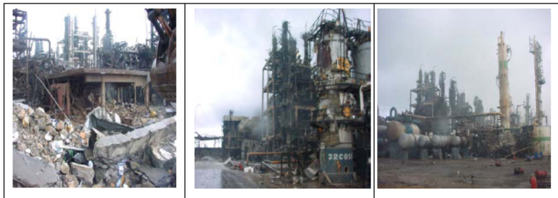
Complexe GL1K (unités 20,30 et 40) après l'accident
